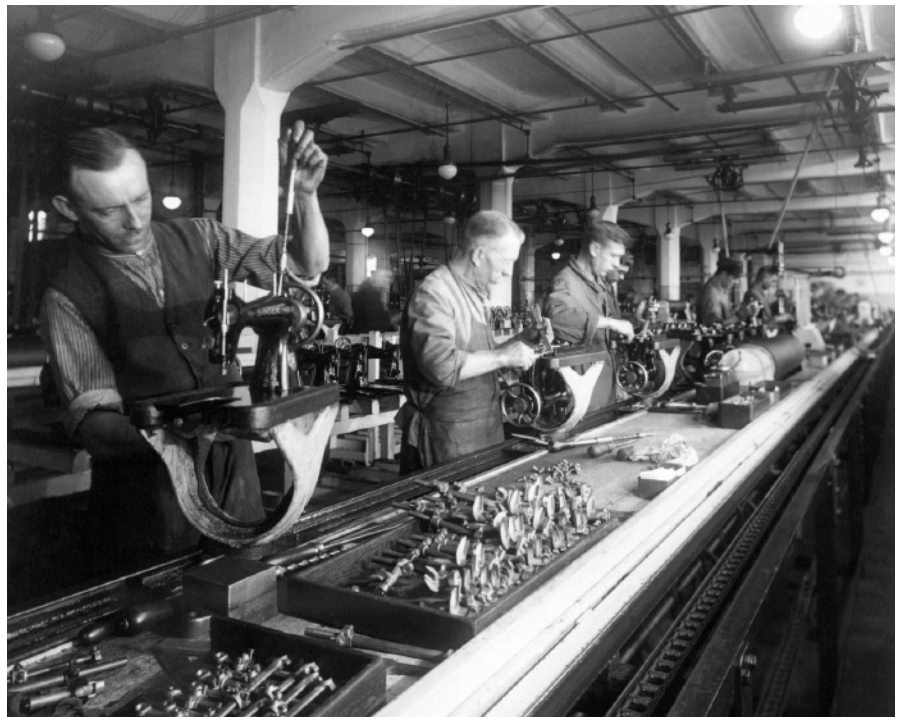
Am Montageband werden in der Singer-Fabrik Wittenberge Nähmaschinen zusammengesetzt.
