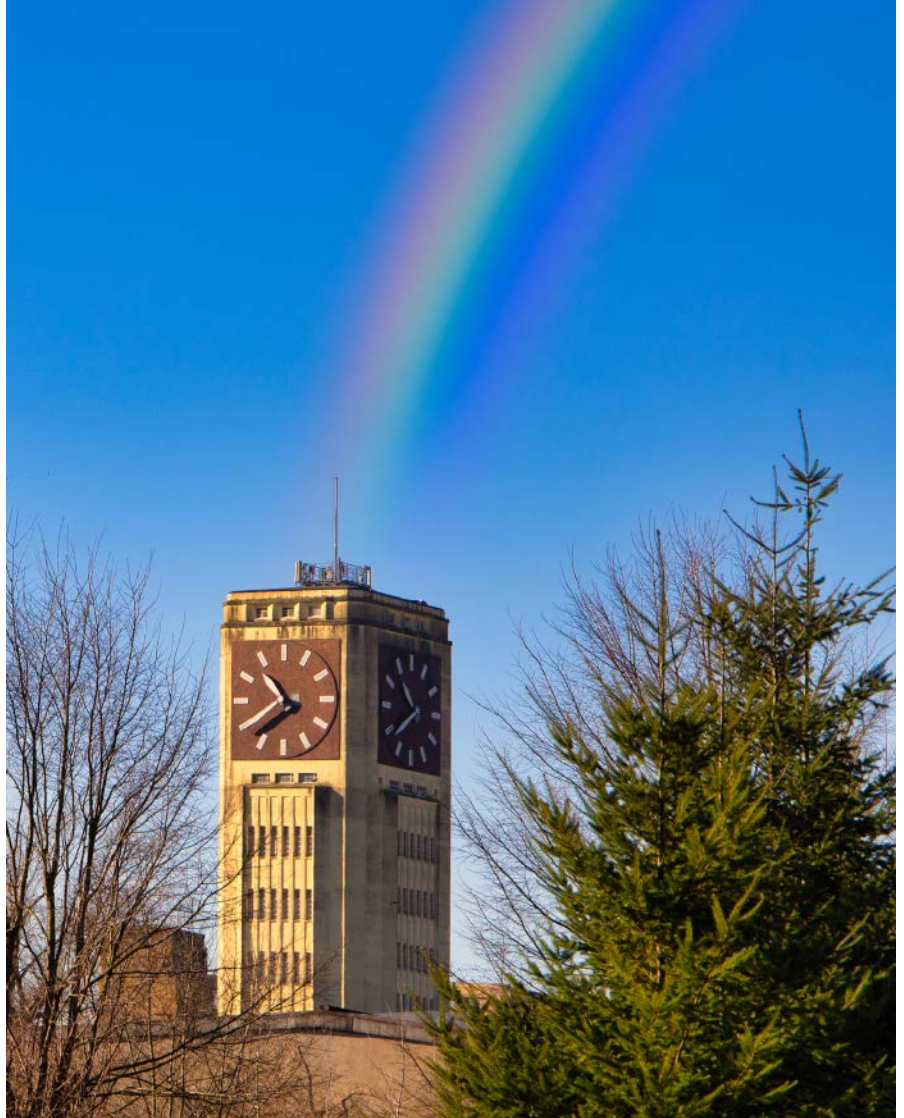
Nach der Werksschließung Anfang der 90er haben sich auf einem Teil des privatisierten Geländes kleinere Firmen angesiedelt.
